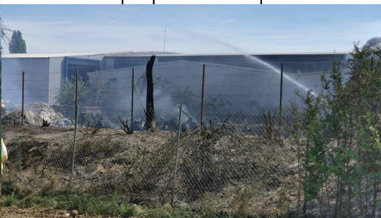
Bardage du bâtiment à gauche déformé légèrement par la chaleur
