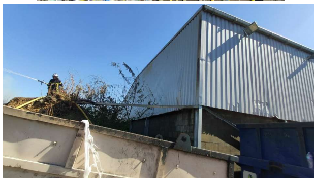
Bardage du bâtiment à gauche déformé légèrement par la chaleur
